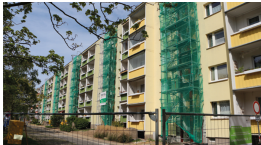
→ Die Häuser der Clausen-Dahl-Straße 27 – 35 erhalten Aufzüge. Die Bauvorbereitungsarbeiten laufen.
