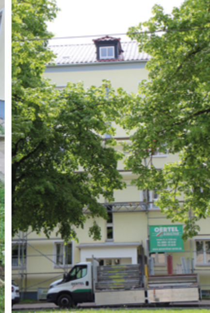
→ An der Münchner Straße 29 – 33 wird das Dach instand gesetzt.
