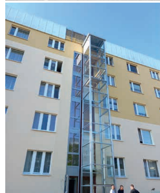
→ An der Rungestraße 9 – 27 wurden Aufzüge angebaut: vorher (oben) – nachher (unten)
