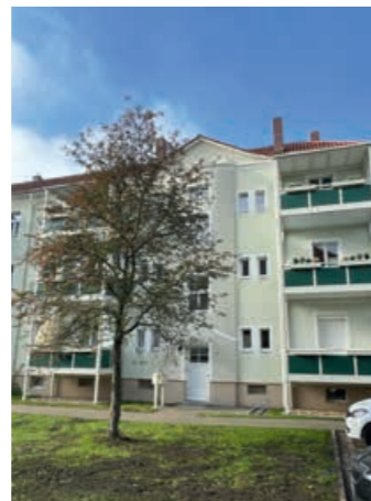
→ Die Häuser der Dohnaer Straße erhielten Balkone.
